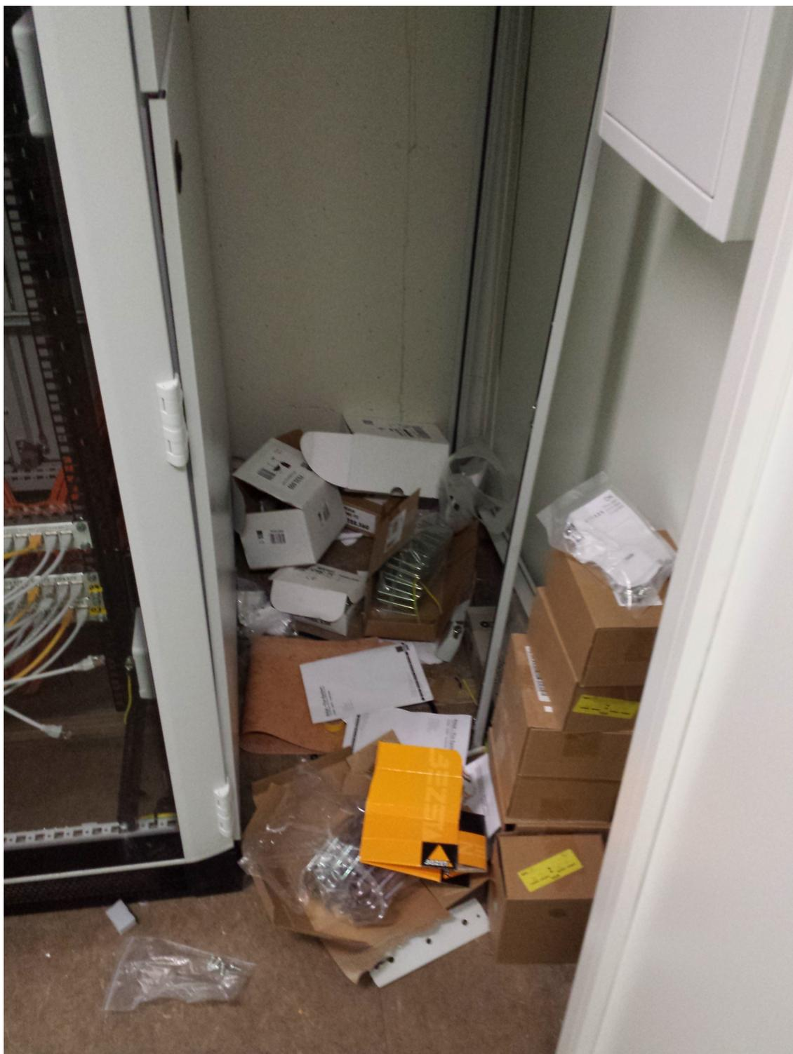
Abbildung 22: Installationsreste nicht entsorgt
