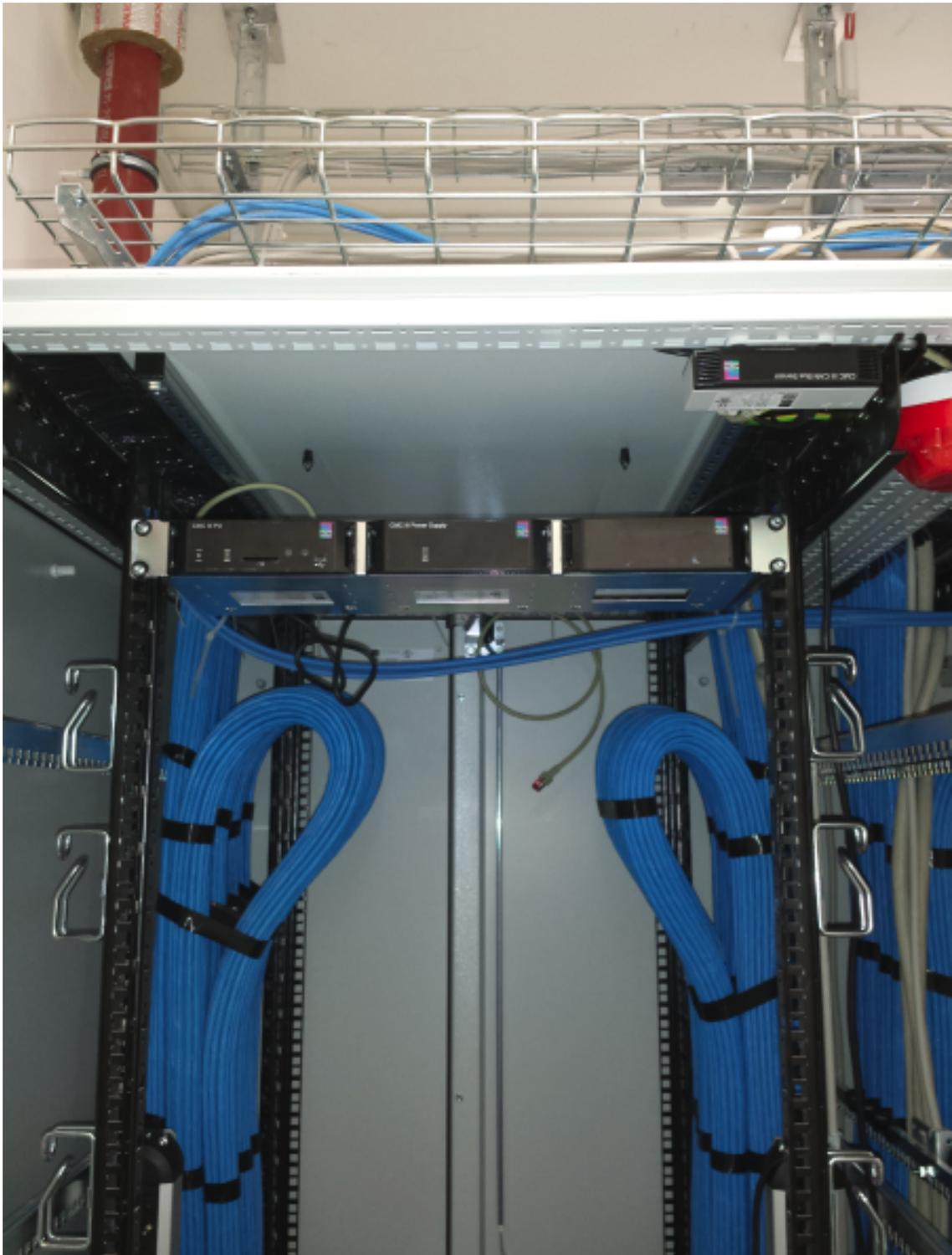
Abbildung 5: Etagenverteiler vorn oben – ohne aktive Komponente(n)
