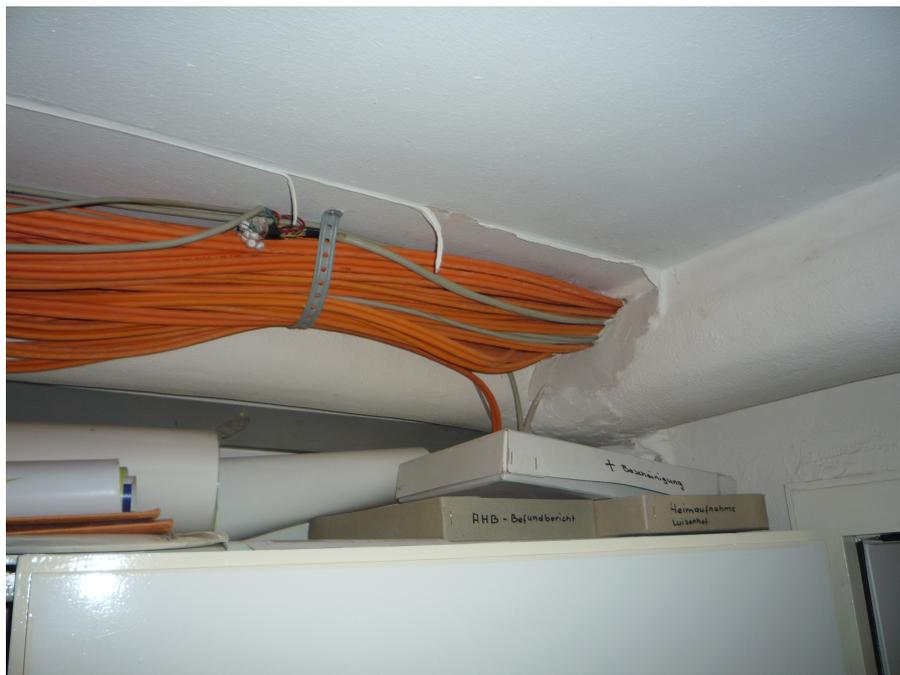
Abbildung 10: Kabelverlegung ohne Kabelbühne (1)
