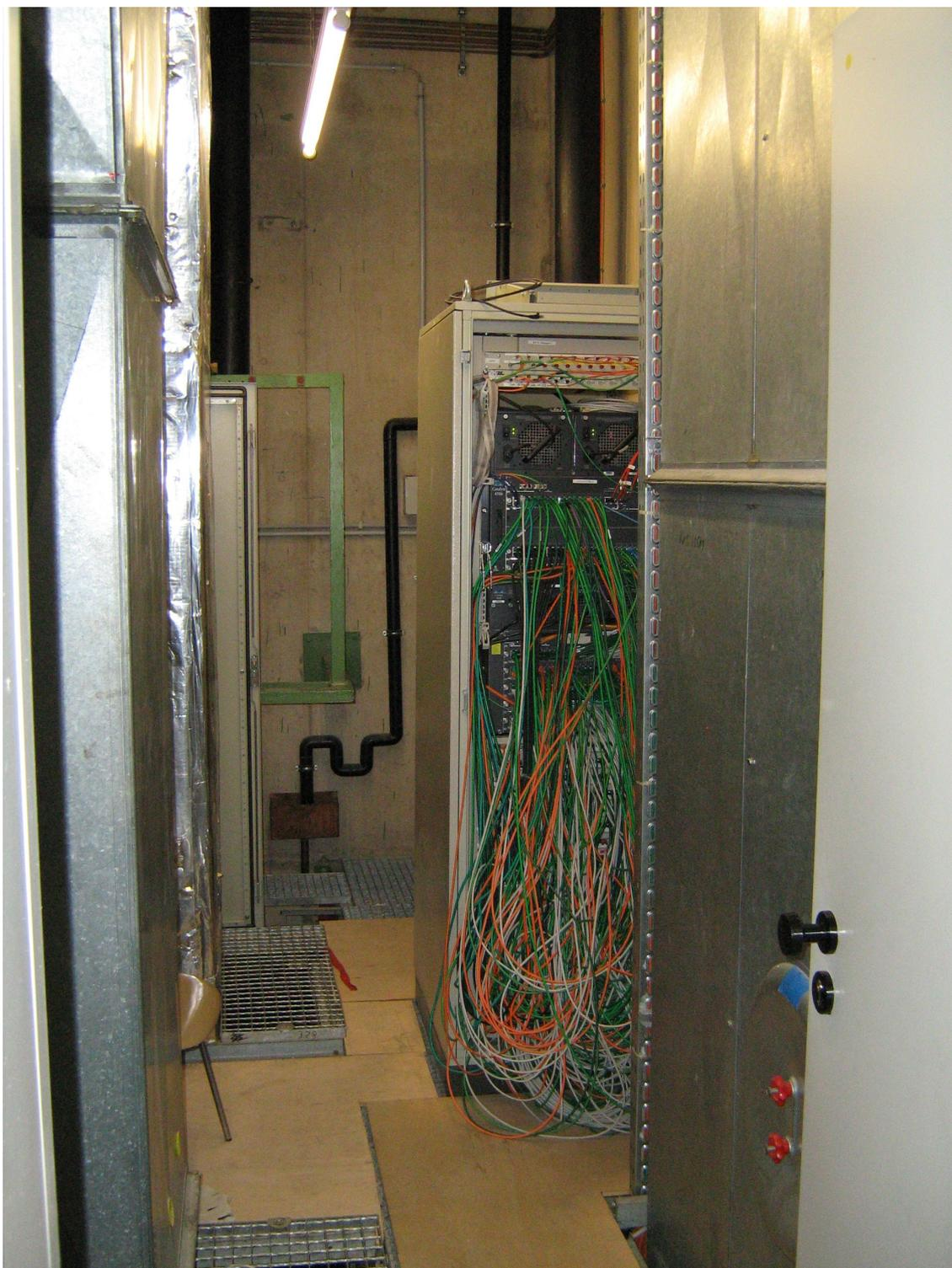
Abbildung 15: Als Datenverteiler ungeeigneter Technikraum
