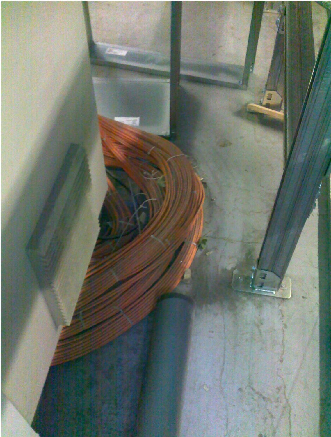
Abbildung 9: Falsche Kabeleinführung in den Netzwerkschrank
